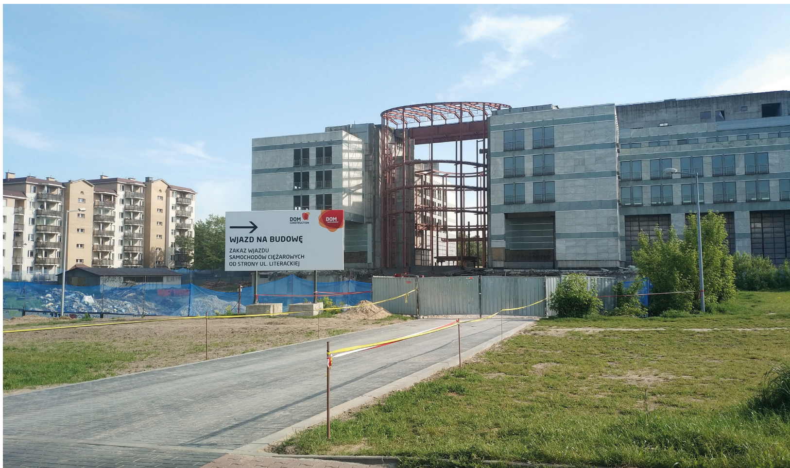
Budynek EuRoPol Gazu w trakcie rozbiórki FOT. materiał prasowy
